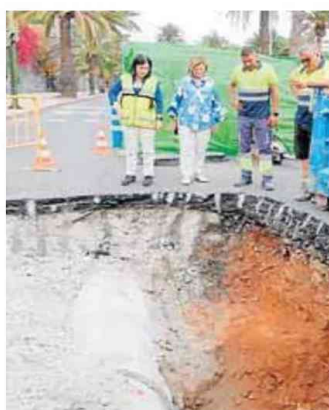
Darias y Medina, en la obra. c7
